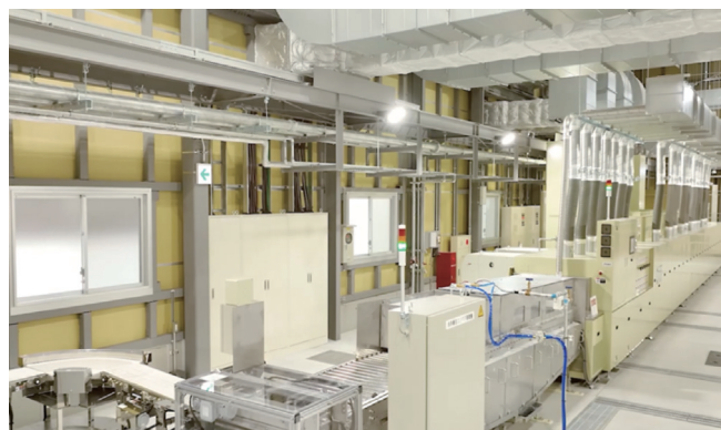
名古屋アミ洗浄工場内部
